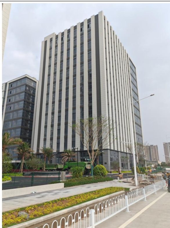
项目南面：园区的 2 栋
