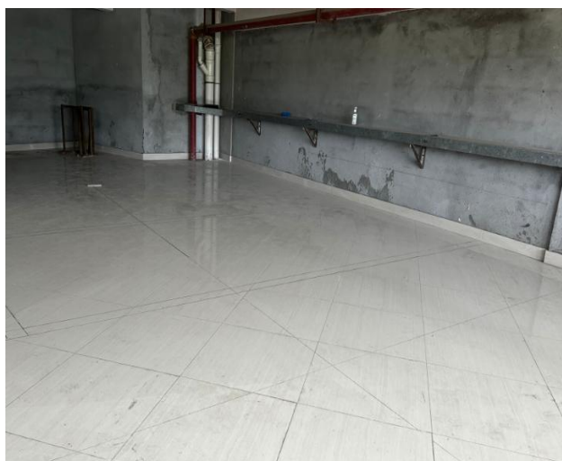
项目1楼空厂房照片
